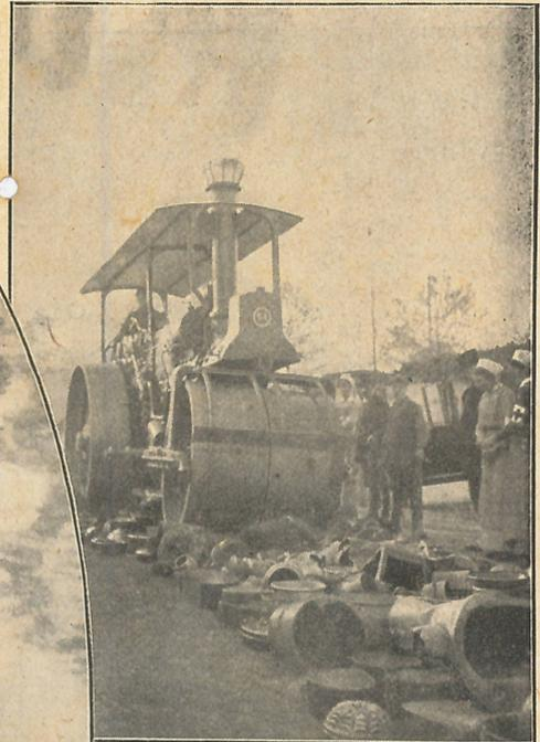
Blattwalzen von gesammeltem Kupfer und Messing für den Transport.
