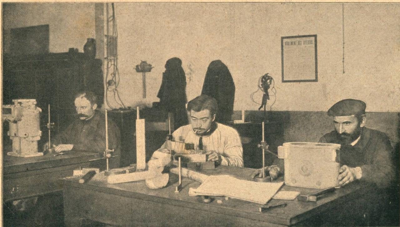
Die fertigen Gussstücke des Motors und Getriebes werden angezeichnet.
