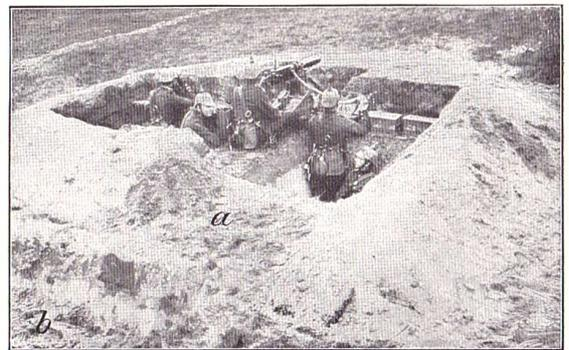
a) Der bildlichen Darstellung wegen ist ein Teil der Rückenwehr freigelassen. b) Grube zur Erdentnahme.
