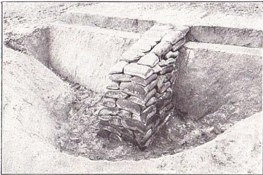
Bild 171 (zu 298). Maschinengewehrdeckung im Gefecht unter Verwendung von Sandsäcken. (Anschlag liegend.)
